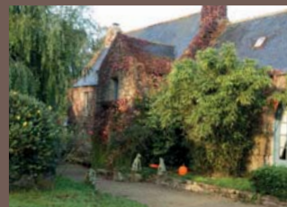
© La Grange de Coatélan
