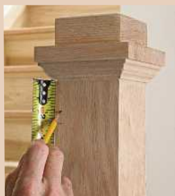
134 Positionner le pilastre
