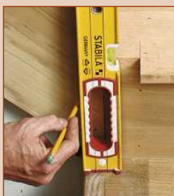
137 Tracer les usinages du pilastre
