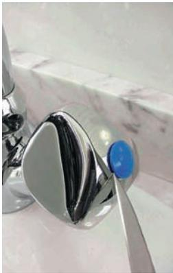
1 - Dans un mélangeur, les têtes sont cachées par les croisillons. Ôtez les pastilles de couleur avec la pointe d'un couteau, puis retirez la vis de fixation du croisillon.
